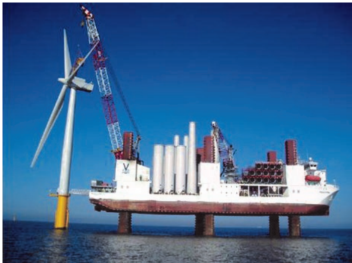
Figura 15 – Instalação Real de uma Grande Unidade Aerogeradora Offshore
