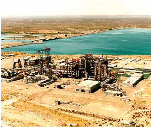
Planta industrial de agua pesada (1994)
